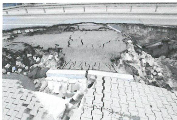
Szczegóły osunięcia gruntu i umocnienia skarpy nasypu wokół konstrukcji wlotu i przepustu, utrata stateczności: przemieszczenie i obrót, osunięcie, pęknięcia i destrukcja żelbetowej konstrukcji pomostu obsługowego wraz ze schodami i ścianami oporowymi oraz infrastrukturą – 2019-06-22, 2019-08-03
