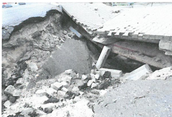
Szczegóły destrukcji nawierzchni jezdni i zatoki postojowej 2019-08-03
