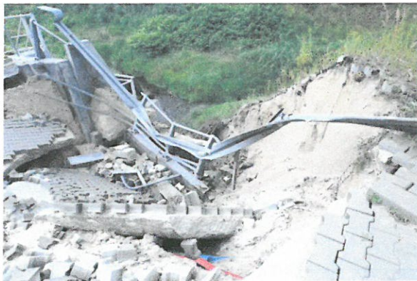
Szczegóły osunięcia gruntu i umocnienia skarpy nasypu wokół konstrukcji wlotu oraz obsunięcia warstw nawierzchni drogi – ulicy Janka Wiśniewskiego wraz z zatoką postojową i infrastrukturą drogową oraz elementami uzbrojenia przy przepuscie od strony ul. Kontenerowej 2019-08-03
