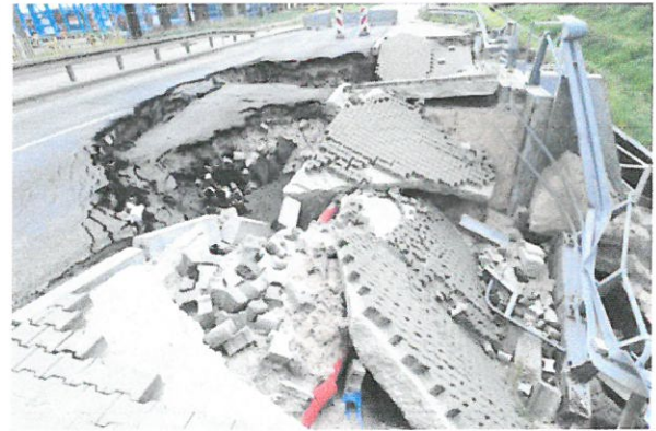
Szczegóły osunięcia gruntu i umocnienia skarpy nasypu wokół konstrukcji wlotu oraz obsunięcia warstw nawierzchni drogi – ulicy Janka Wiśniewskiego wraz z zatoką postojową i infrastrukturą drogową oraz elementami uzbrojenia przy przepuscie od strony ul. Kontenerowej 2019-08-03
