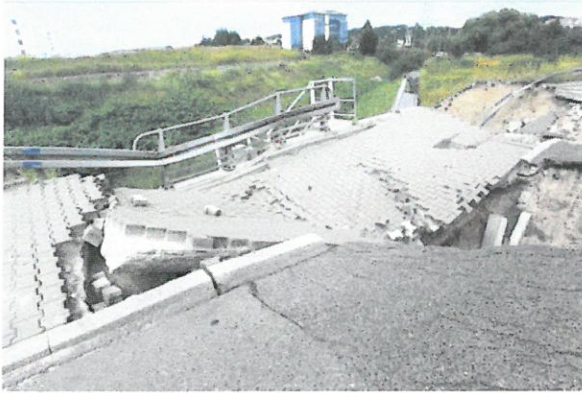
Szczegół osunięcia gruntu i umocnienia skarpy nasypu wokół konstrukcji wlotu oraz obsunięcia warstw nawierzchni drogi – ulicy Janka Wiśniewskiego wraz z zatoką postojową i infrastrukturą drogową oraz elementami uzbrojenia przy przepuscie od strony ul. Logistycznej 2019-08-03
