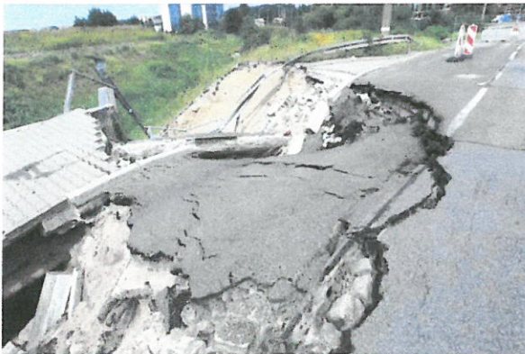
Szczegół osunięcia gruntu i umocnienia skarpy nasypu wokół konstrukcji wlotu oraz obsunięcia warstw nawierzchni drogi – ulicy Janka Wiśniewskiego wraz z zatoką postojową i infrastrukturą drogową oraz elementami uzbrojenia przy przepuscie od strony ul. Logistycznej 2019-08-03
