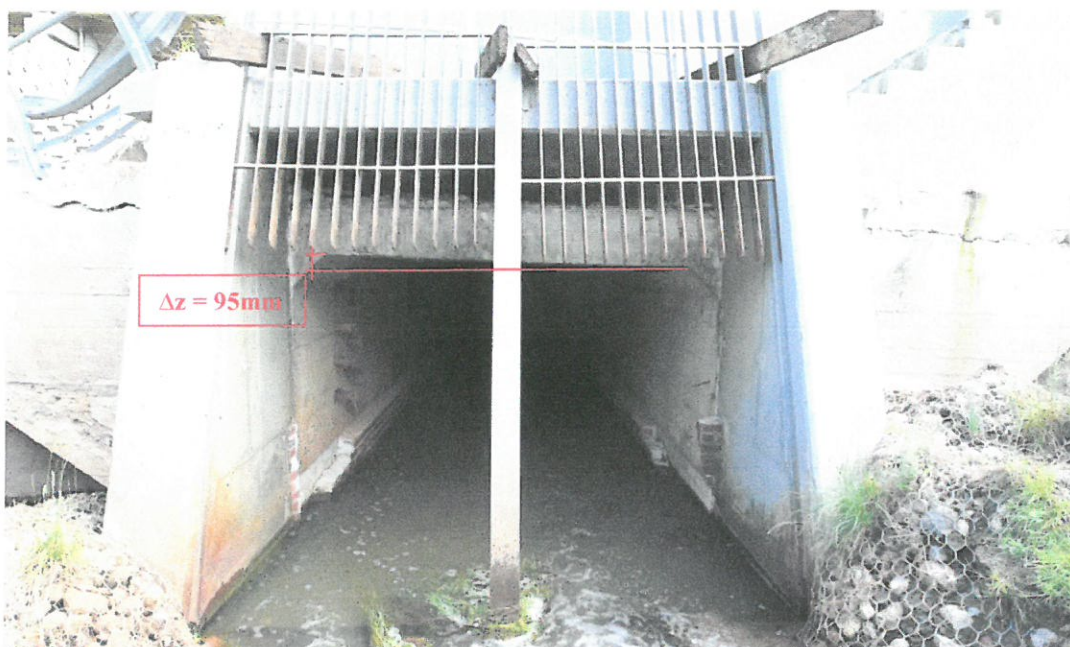
Określenie wartości przemieszczeń sekcji pierwszej na wlocie przepustu 2019-08-03
