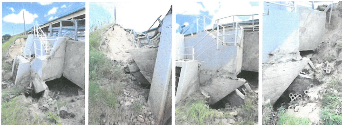
Szczegóły osunięcia gruntu i umocnienia skarpy nasypu wokół konstrukcji wlotu i przepustu, utrata stateczności: przemieszczenie i obrót, osunięcie, pęknięcia i destrukcja żelbetowej konstrukcji pomostu obsługowego wraz ze schodami i ścianami oporowymi oraz infrastrukturą – 2019-06-22, 2019-08-03
