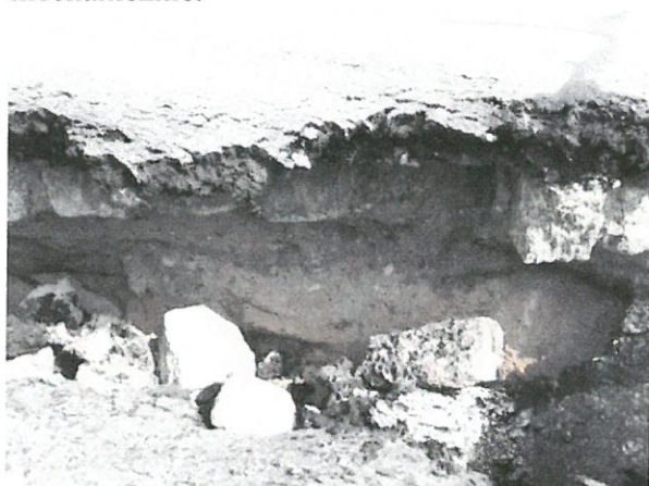
Widok na warstwy w obrębie jezdni – stan po awarii 2019-08-03
