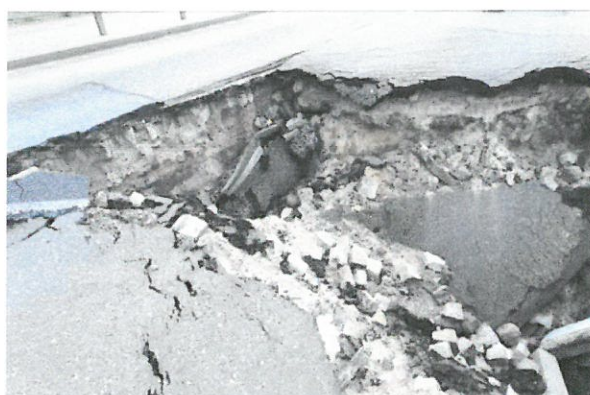
Szczegóły osunięcia gruntu i umocnienia skarpy nasypu wokół konstrukcji wlotu i przepustu, utrata stateczności: przemieszczenie i obrót, osunięcie, pęknięcia i destrukcja żelbetowej konstrukcji pomostu obsługowego wraz ze schodami i ścianami oporowymi oraz infrastrukturą – 2019-06-22, 2019-08-03
