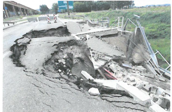
Szczegół osunięcia gruntu i umocnienia skarpy nasypu wokół konstrukcji wlotu oraz obsunięcia warstw nawierzchni drogi – ulicy Janka Wiśniewskiego wraz z zatoką postojową i infrastrukturą drogową oraz elementami uzbrojenia przy przepuscie od strony ul. Logistycznej 2019-08-03
