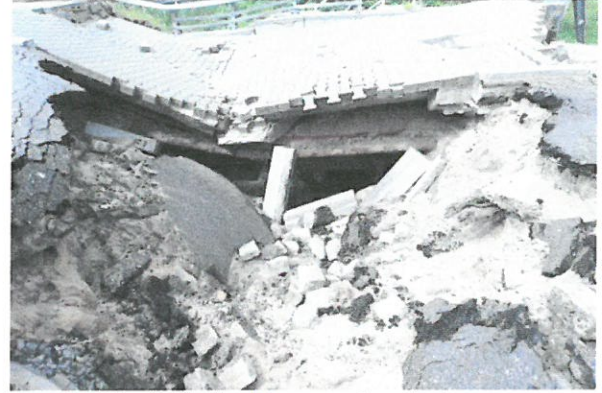
Szczegół osunięcia gruntu i umocnienia skarpy nasypu wokół konstrukcji wlotu oraz obsunięcia warstw nawierzchni drogi – ulicy Janka Wiśniewskiego wraz z zatoką postojową i infrastrukturą drogową oraz elementami uzbrojenia przy przepuscie od strony ul. Logistycznej 2019-08-03
