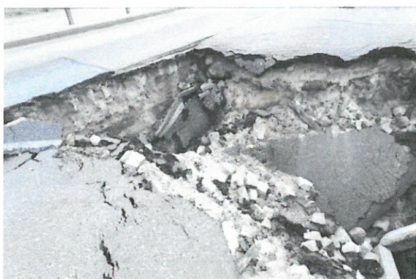
Szczegóły destrukcji nawierzchni jezdni i zatoki postojowej 2019-08-03
