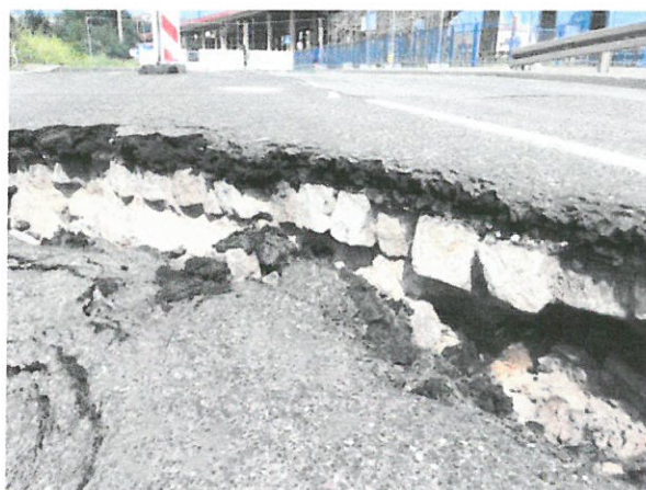
Widok na warstwy w obrębie jezdni – stan po awarii 2019-08-03
