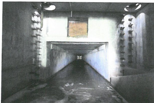
Widok wnętrza odcinka „A” pomiędzy komorą spadową i rewizyjną 2019-08-03
