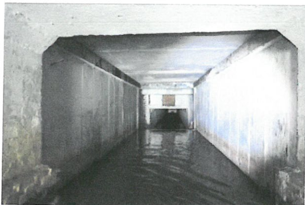
Widok wnętrza odcinka połączeniowego przepustu pomiędzy drugą sekcją przepustu ramowego, a komorą spadową 2019-08-03
